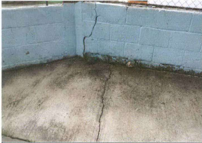
Foto1: MEJORAMIENTO E INSTALACIÓN DE CIRCULACIÓN DEL MURO PERIMETRAL
